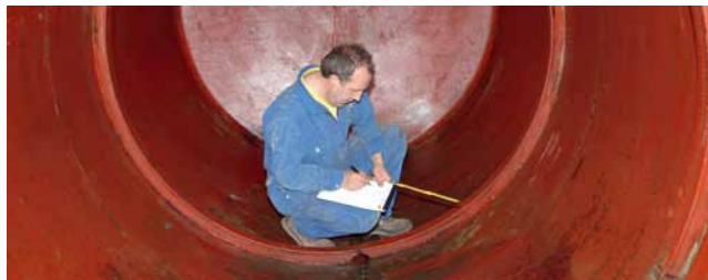
1. Nettoyage de la citerne et prise des dimensions pour la confection de l'enveloppe intérieure
