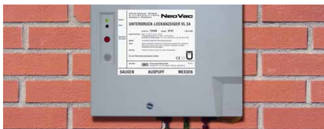
4. Pose et mise en service du détecteur de fuites
